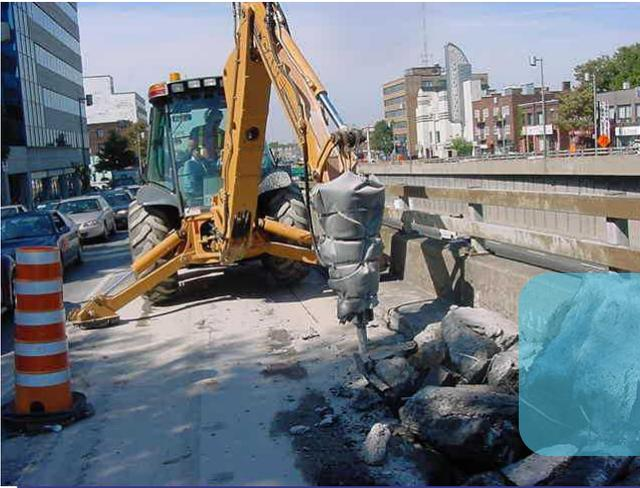
Tests réalisés avec un marteau hydraulique insonorisé : près de **10 dBA** de réduction
