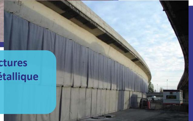
**Principalement** utilisées pour des travaux **sous des structures** mais peuvent être installées **au sol sur une structure métallique**
